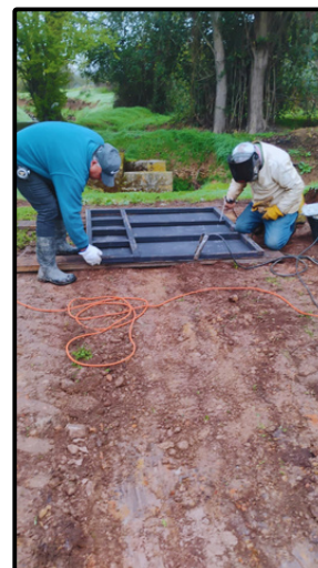
Armado de compuertas, canal El Álamo.
