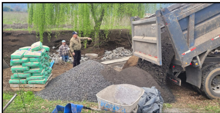
1.Descarga de material, canal Las Lomas. 2.Revestimiento en Canal Panguilemo.
