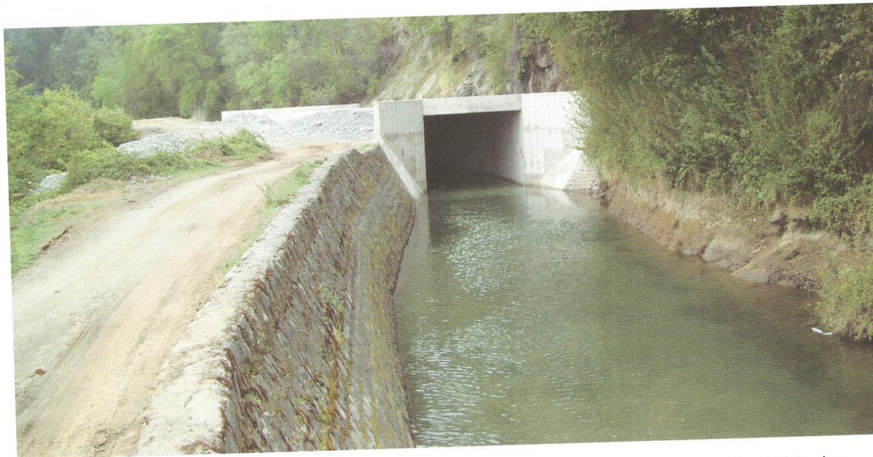
Foto N°4: Cajón de Hormigón armado para prevenir el colapso del canal en una zona de derrumbes habituales.
