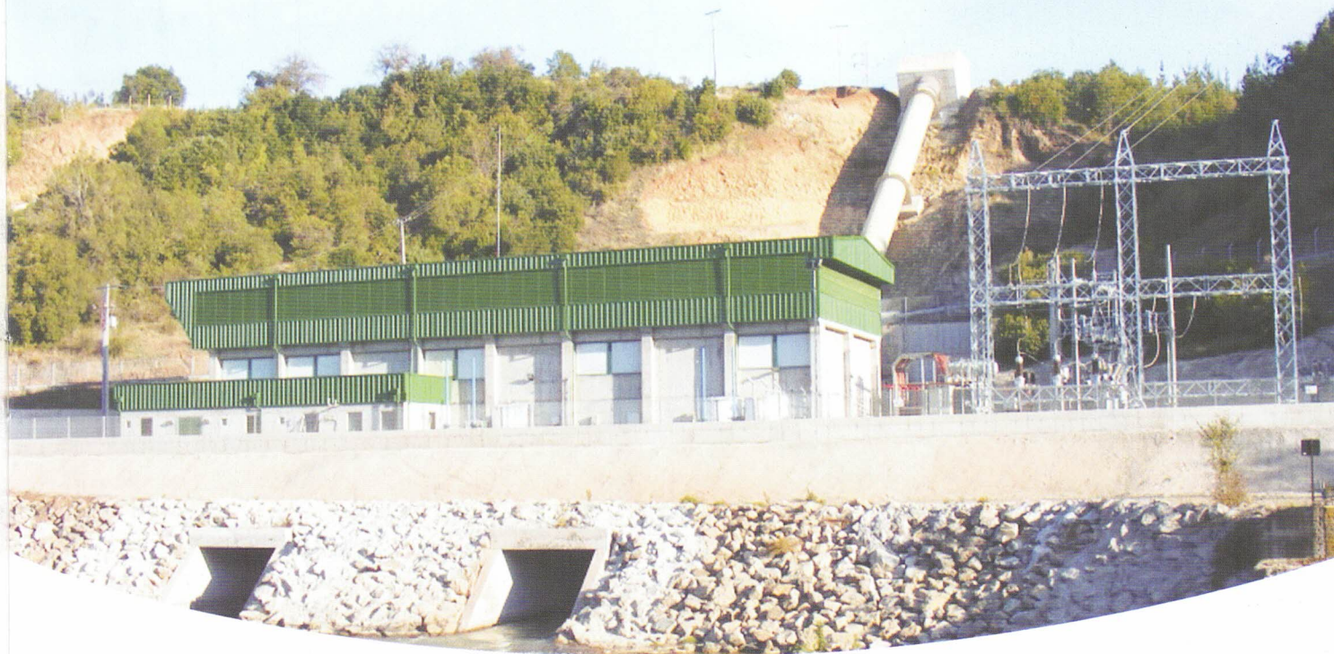
Central Hidroeléctrica de paso "Mariposas"
