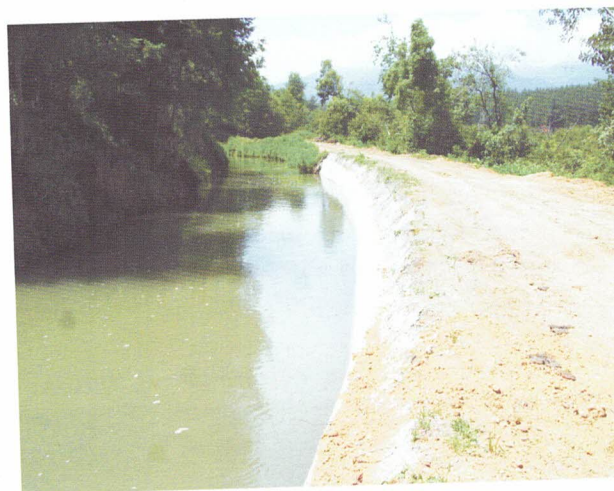
Foto N°3 Muros de Hormigón Armado con contrafuertes para reparar los muros dañados.
