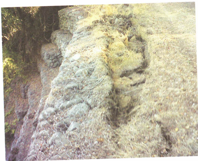
Foto N°2 Reparación de una obra antigua de gaviones la cual resulto seriamente dañada.
