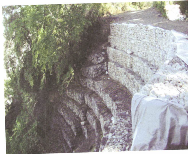
Foto N°2 Reparación de una obra antigua de gaviones la cual resulto seriamente dañada.
