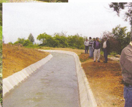
Reparación de Bocatoma y Construcción de Revestimiento Canal Santa Rosa y su derivado El Manzano Construido por Soc. Constructora Patricio Galván
