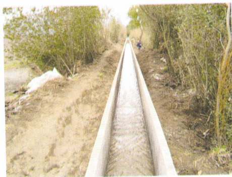
Construcción de Revestimiento Canal Bramadero Concurso N° 04-2003, Ley 18.450, Costo Total del Proyecto 2.446,98 U.F. Construido por Soc. Constructora y de Transporte Vera y Cía. Ltda.-
