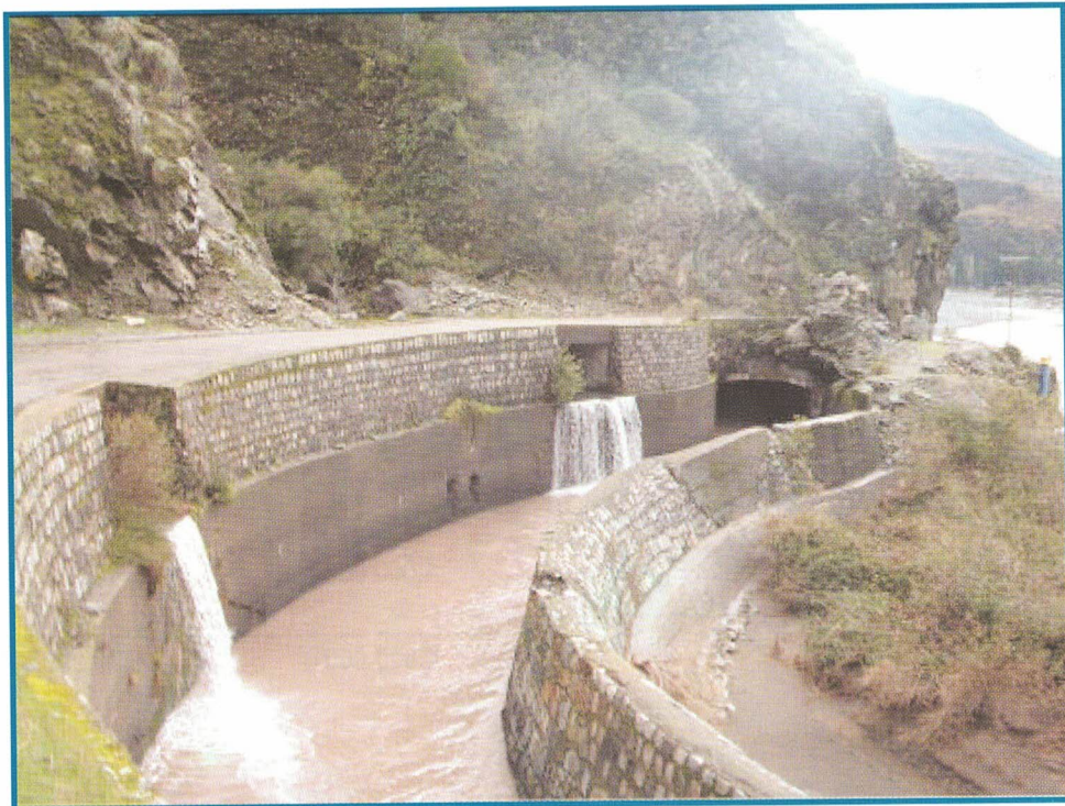
Canal Maule Alto Primera Sección, sector Armerillo
