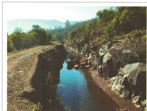
Canal Maule Alto km. 0350
