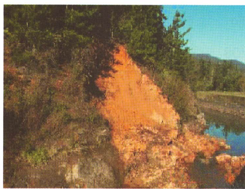
Canal Maule Alto km. 0750
