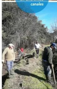
Trabajos de mantención en diferentes canales
