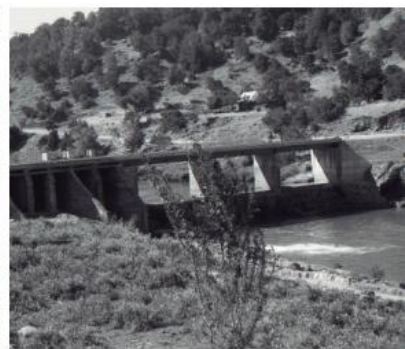
Barrera en el río Lircay de la bocatoma carretones.
