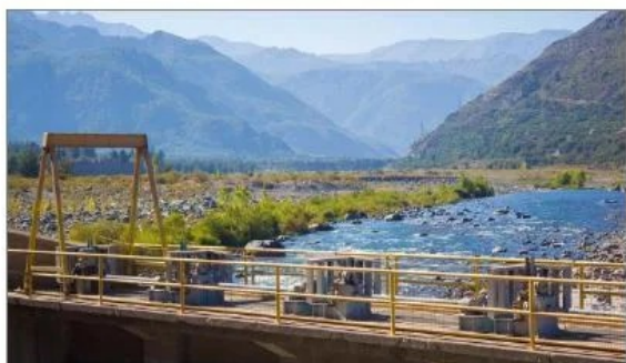
Motorización Compuertas de Armerillo
