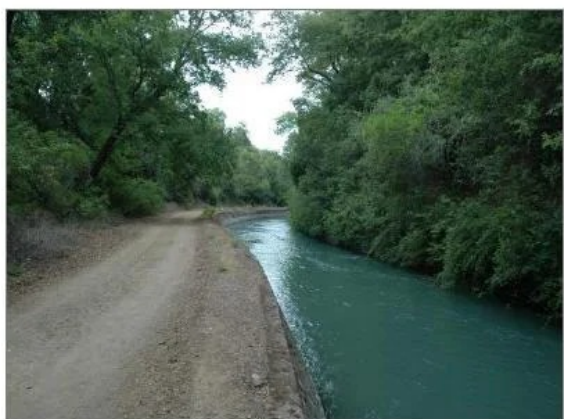
Revestimiento Canal Maule Norte Alto, segunda sección kilómetro 50
