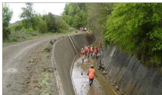
Revestimiento Canal Maule Norte Bajo (tercera etapa)
