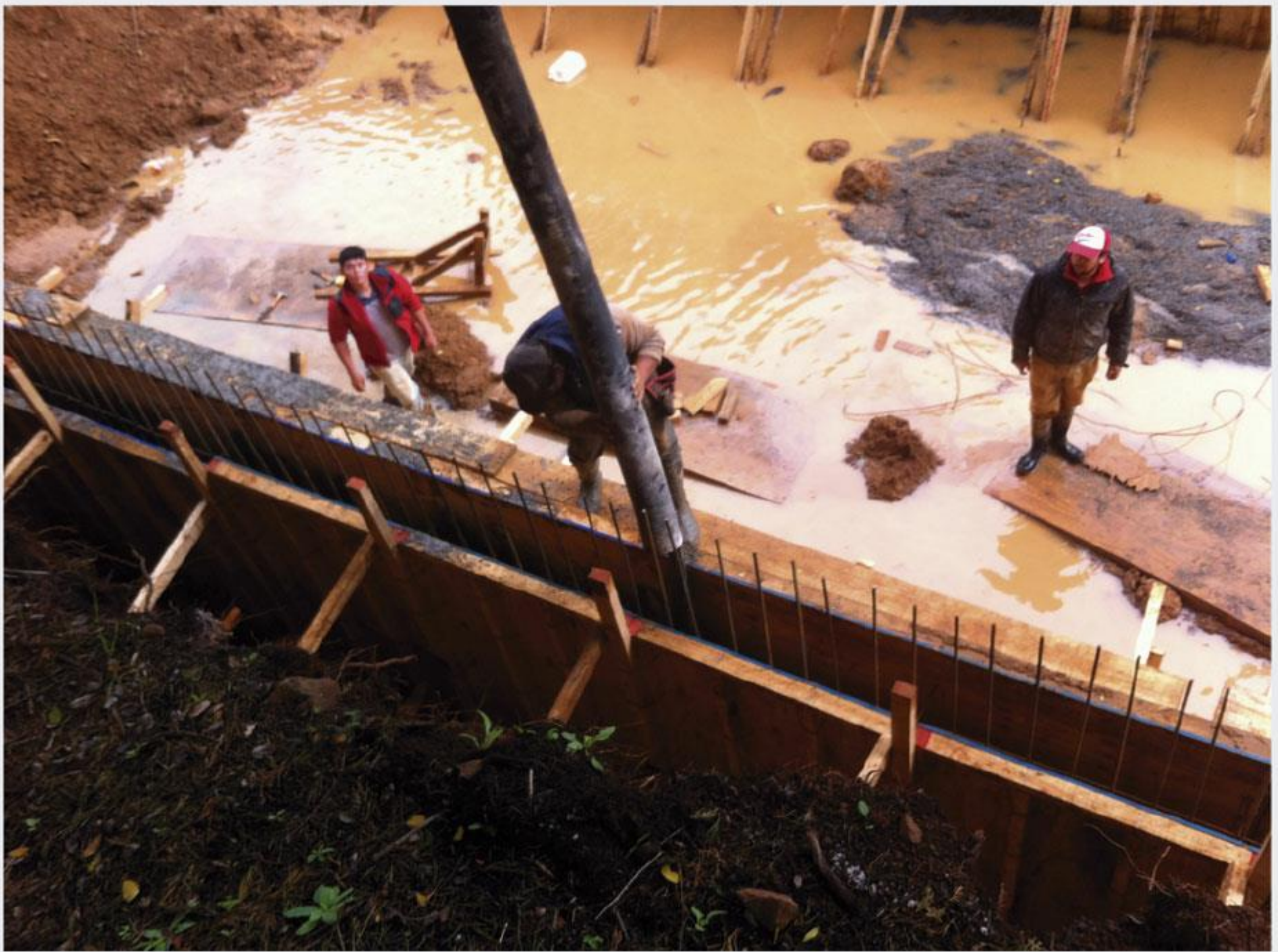
Fase constructiva aforador La Católica
