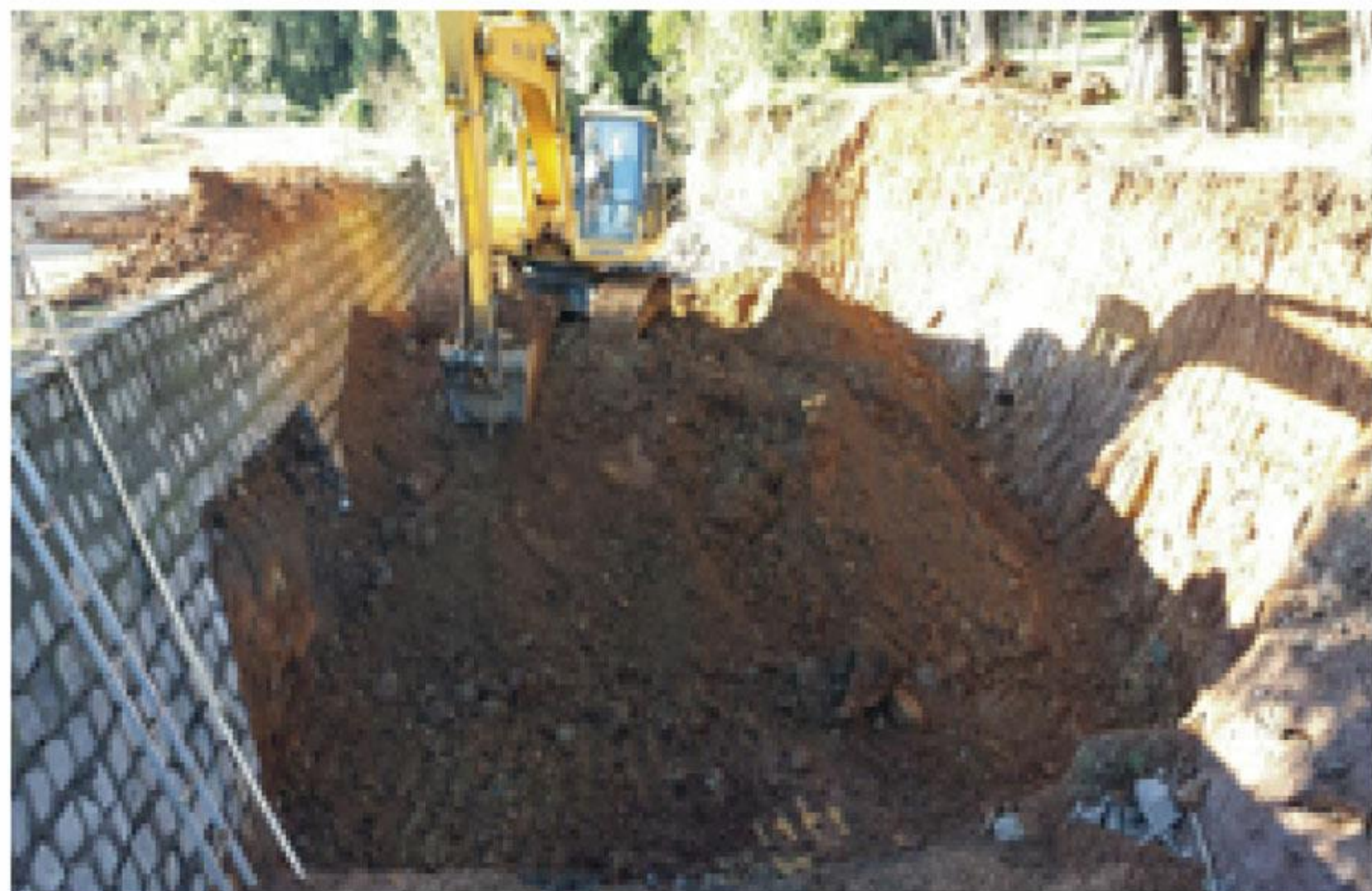
Construcción Aforador Derivado Canal Maule Norte Alto Km 17,8 Sector La Católica 2014. Nos permite controlar los caudales en periodo de lluvias y lo entregado a central Mariposas y 2ª Sección del Alto.
