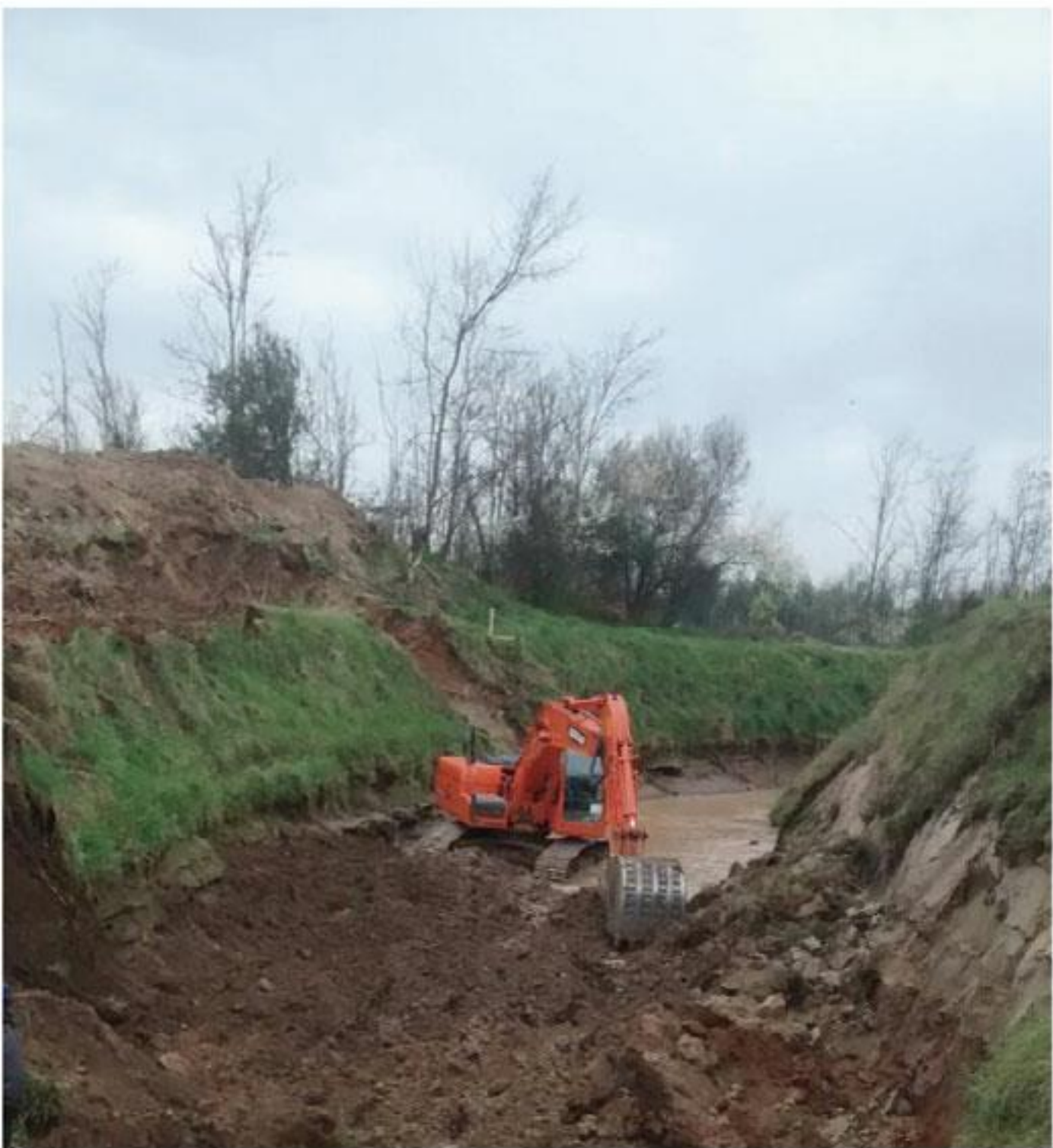
Fase Constructiva Aforador Derivado Canal Maule Bajo sector Cumpeo
