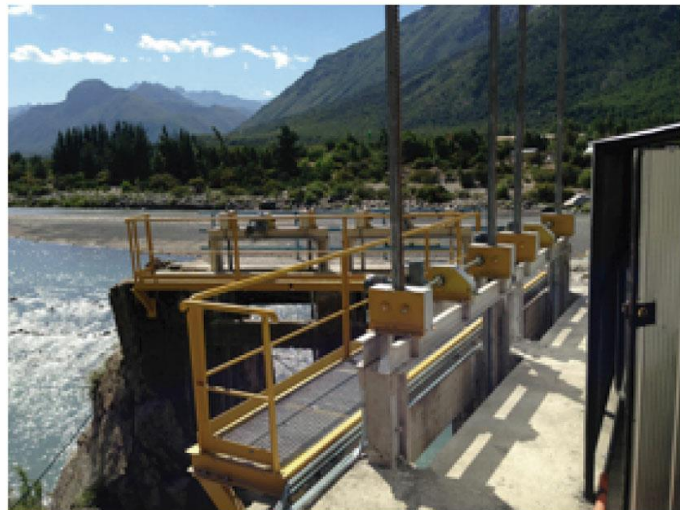
Cambio de Compuertas y Motorización Las Lajas 2014
