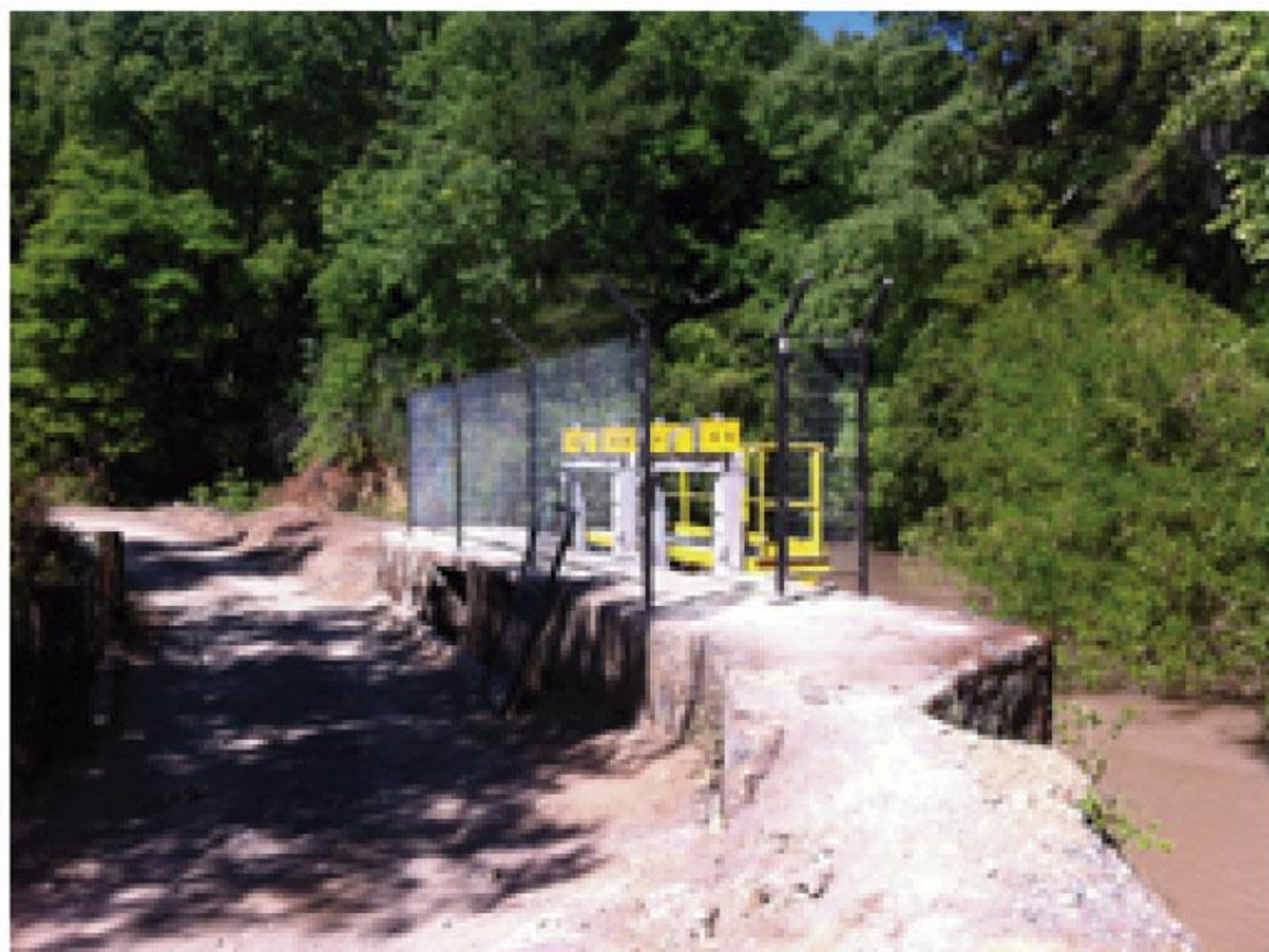
Cambio de Compuertas y Motorización Las Chacras 2014
