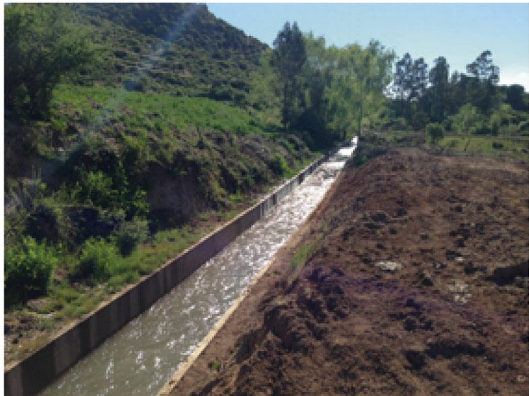
Revestimiento Canal Villalobos Alto 2014
