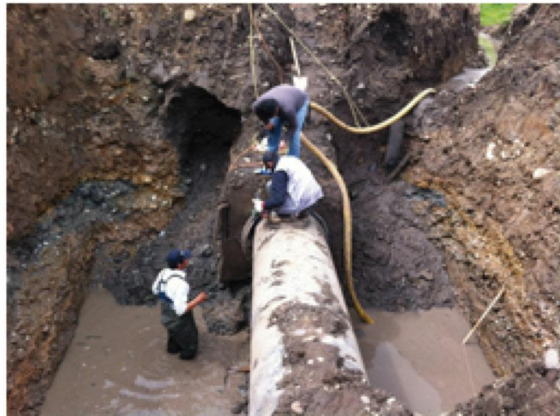
Reparación Sifón Canal Pelarco Viejo 2014
