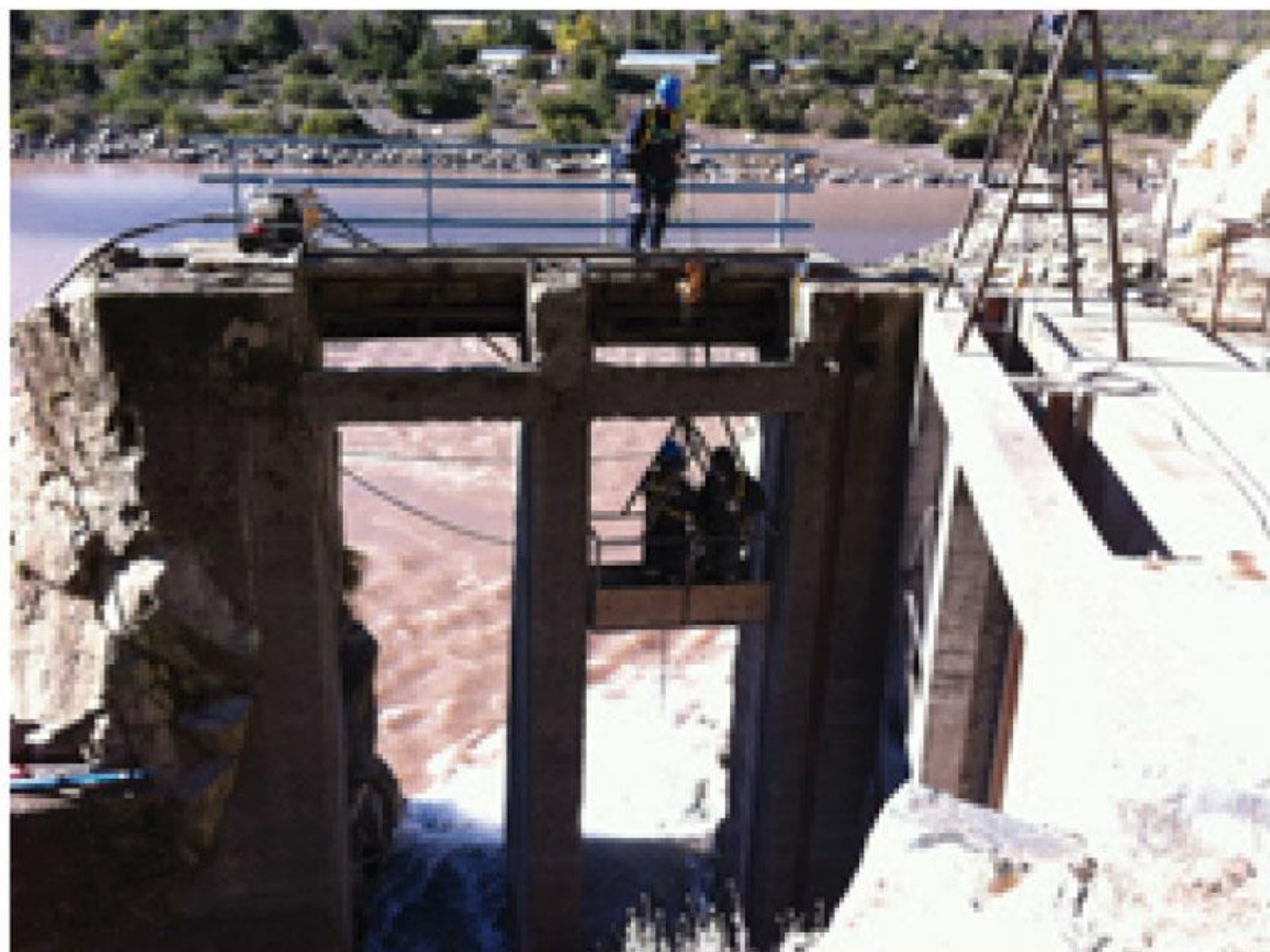
Cambio de Compuertas y Motorización Las Lajas 2014
