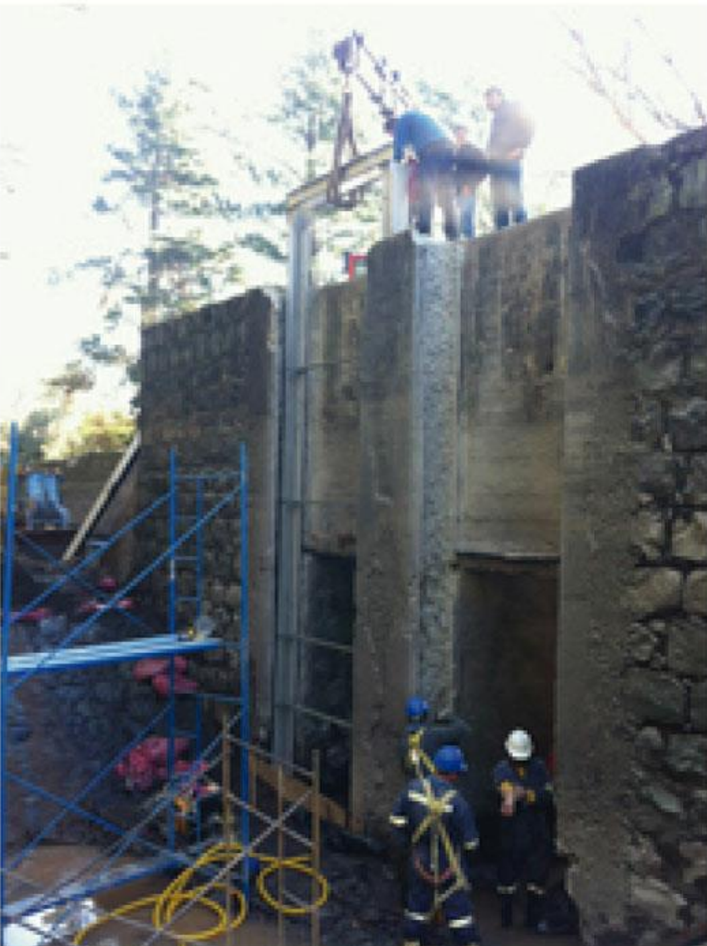
Cambio de Compuertas y Motorización Los Boldos 2014
