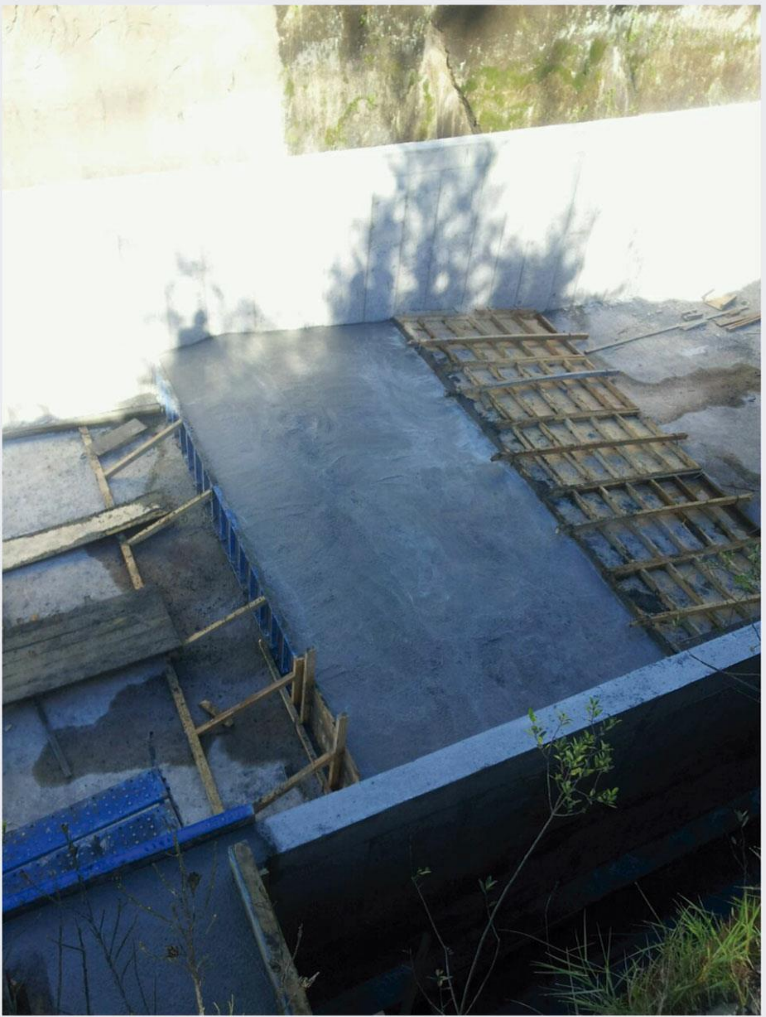
Fase constructiva estación de aforo Huapi
