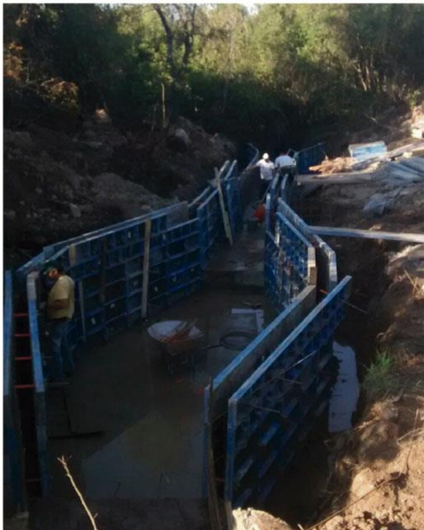
Construcción Aforador Canal San Francisco 2014
