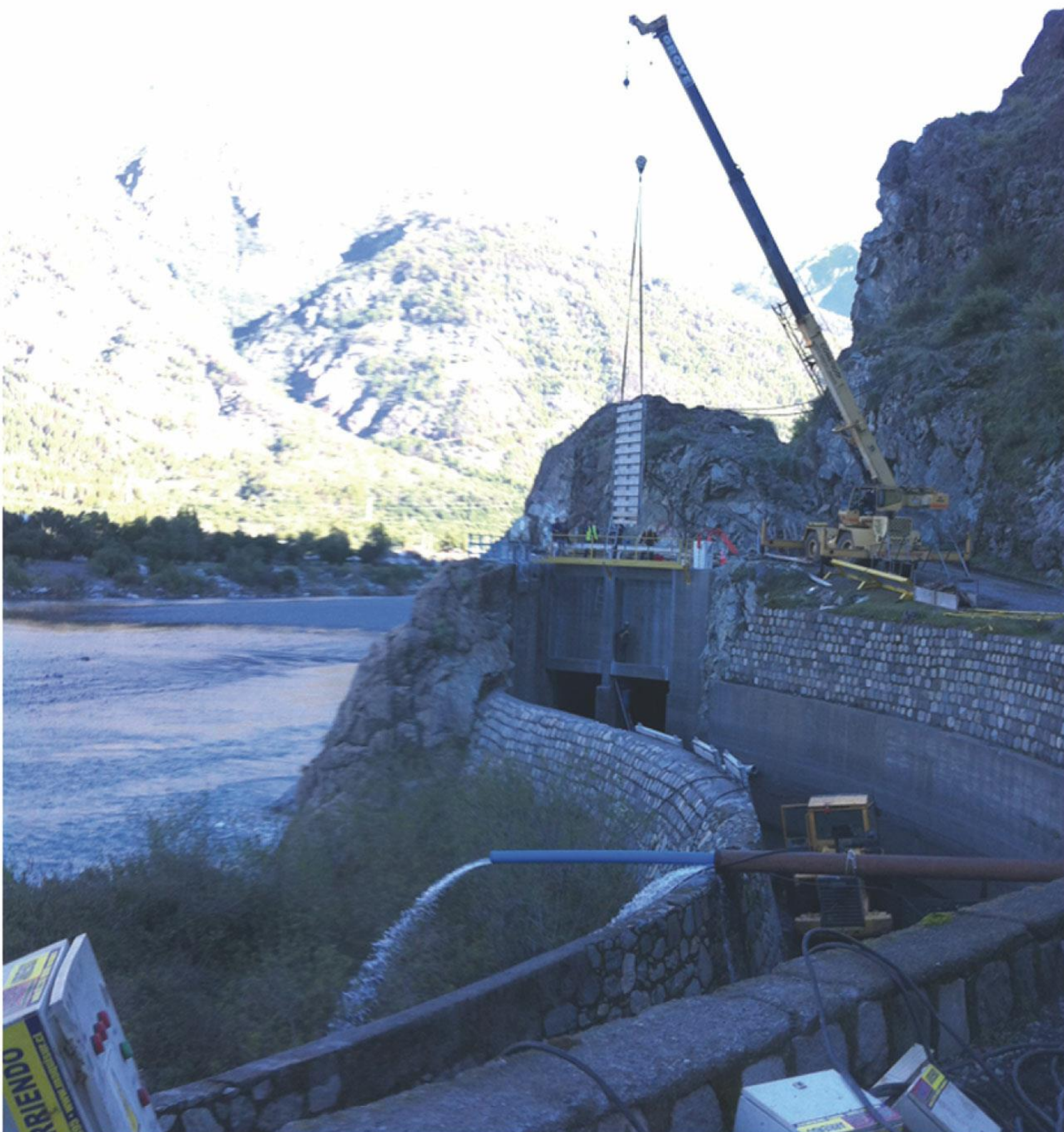
Montaje de hojas compuerta Las Lajas
