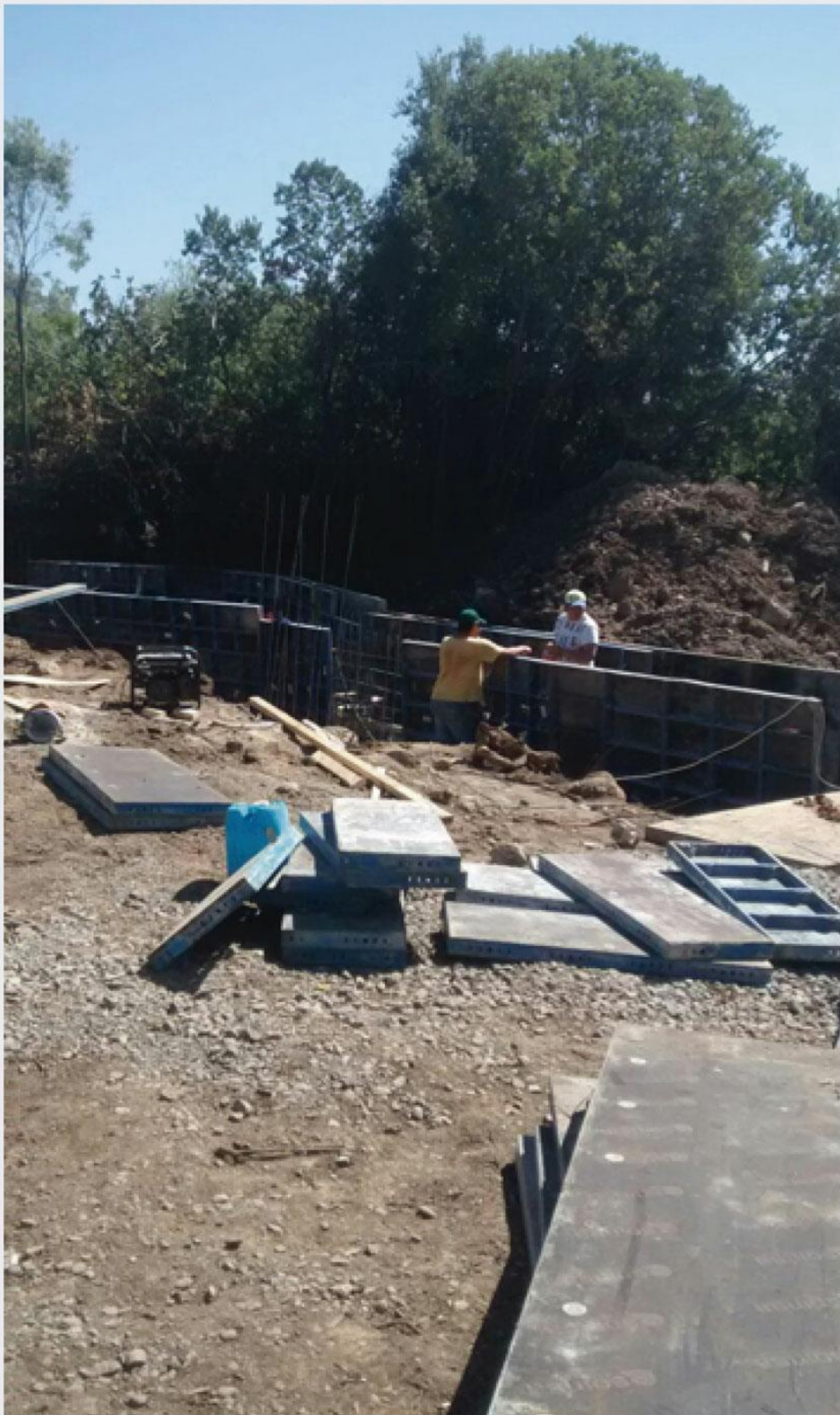
Construcción aforador Canal San Francisco
