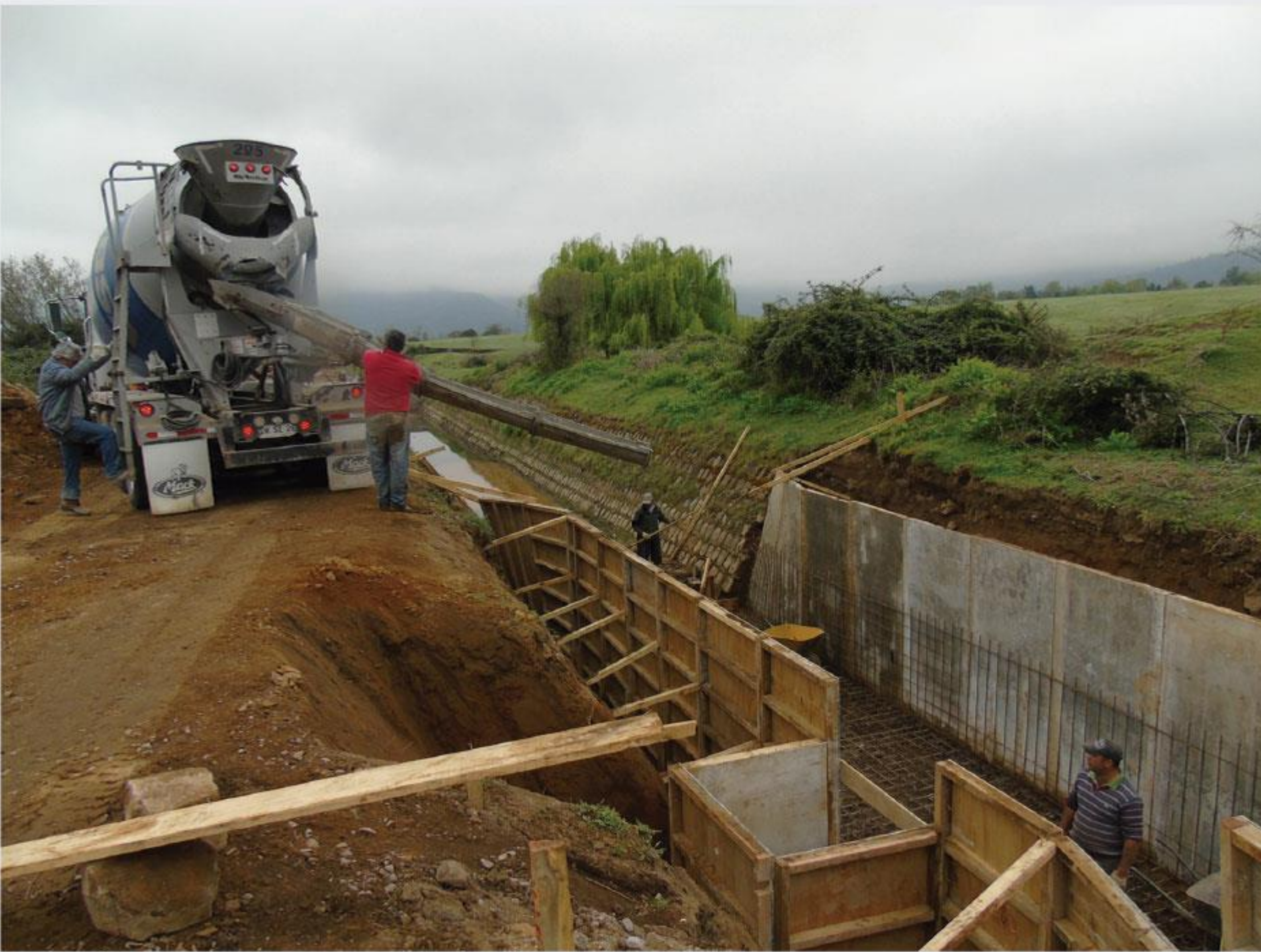
Fase constructiva aforador Las Astillas, que permite conocer el caudal al final del Derivado CMNA.
