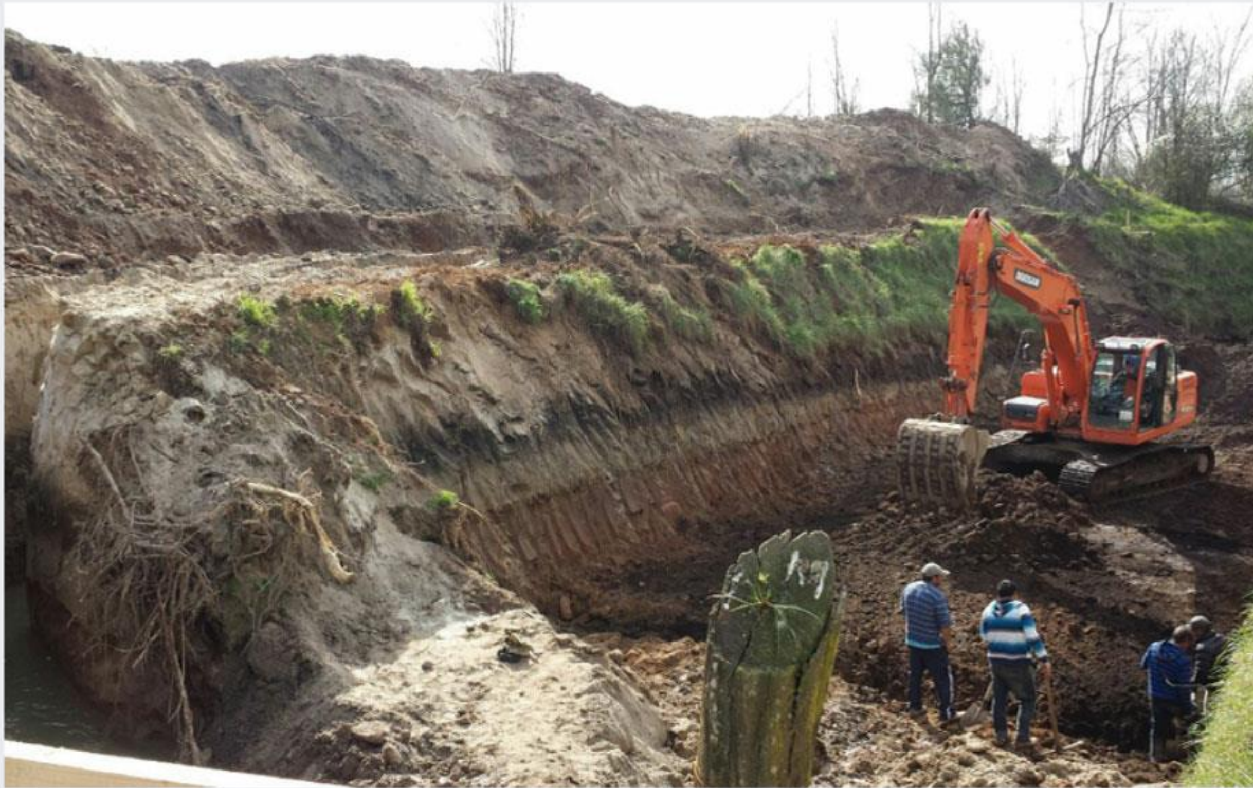
Construcción aforador Derivado Canal Maule Norte Bajo 2ª Sección
