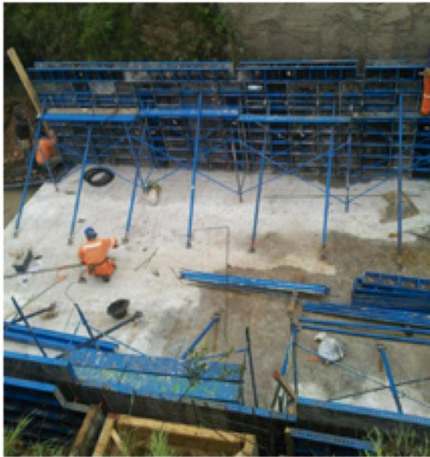
Construcción Aforador Derivado Canal Maule Norte Bajo 2ª Sección Sector Huapi 2014. Permite medir las aguas entregadas para el riego de más de 20.000 hectáreas
