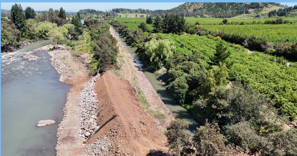
CANAL PROVIDENCIA Km 0,2 (Puente de Lata)
