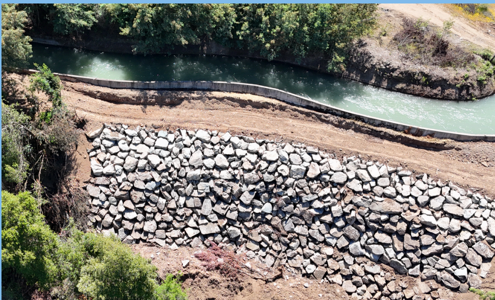
CANAL PROVIDENCIA KM 6.9
