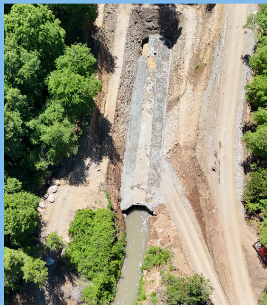
TUNEL LA GREDA TERMINADO
