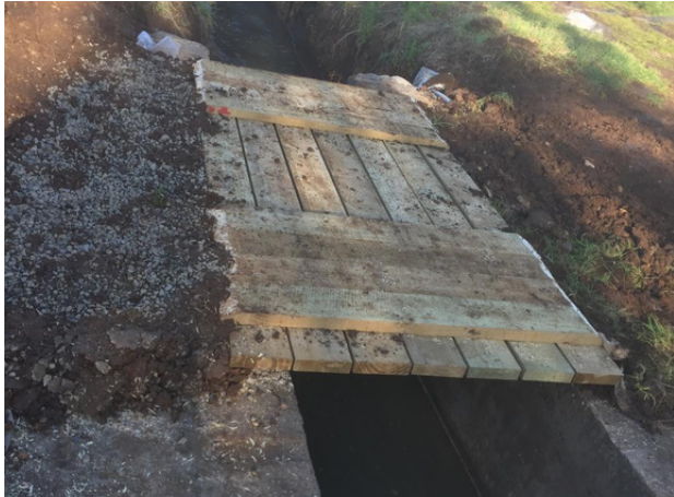
PUENTE C. VERGARA
