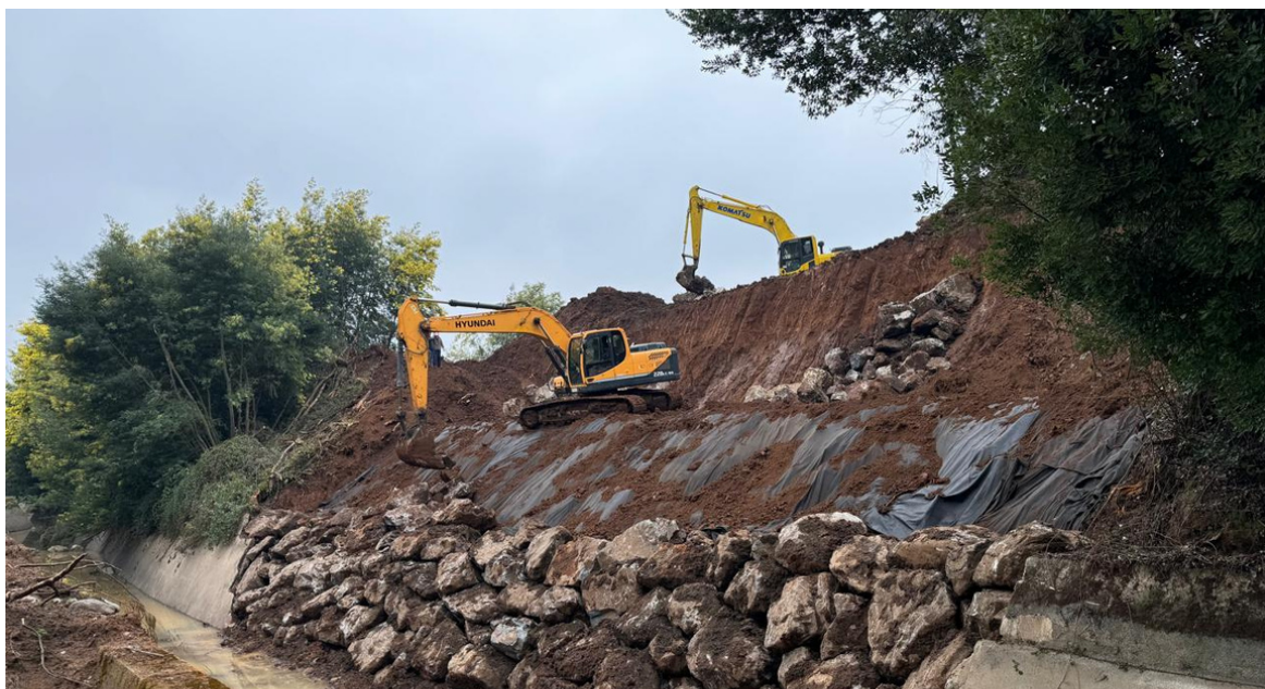
ENROCADO CMNB SEGUNDA SECCION TERMINADO
