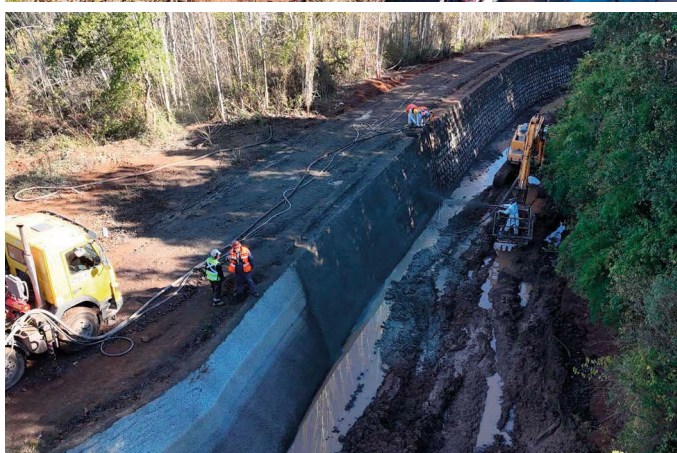
1. Construcción de revestimiento con shotcrete canal Maule Norte Alto, sector Paso Nevado para eliminar filtraciones.
