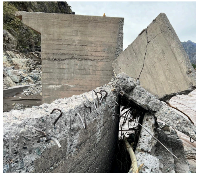
Muro de Bocatoma Armerillo Junio 2024
