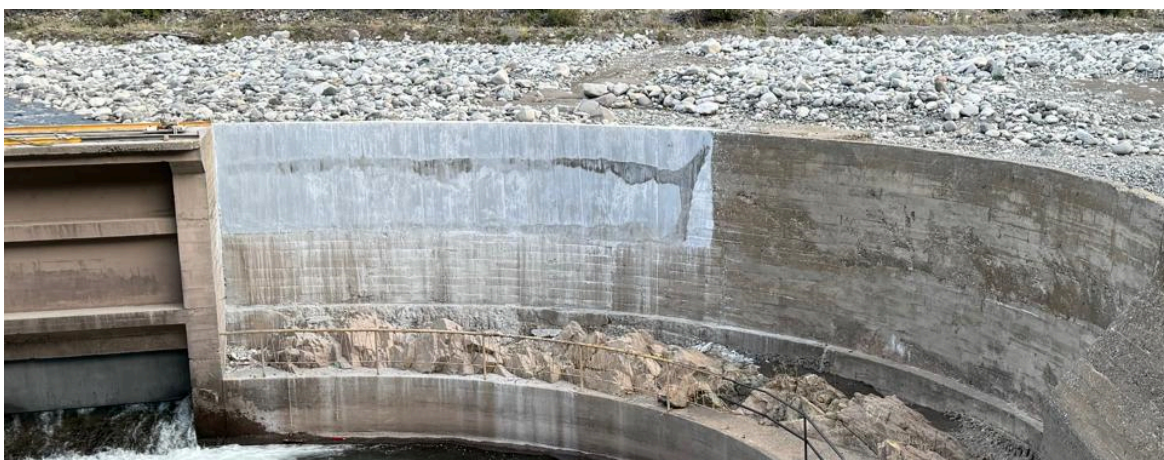
Muro de Bocatoma Armerillo Septiembre 2024
