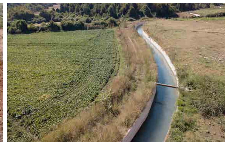
Revestimiento Canal Mariposas
