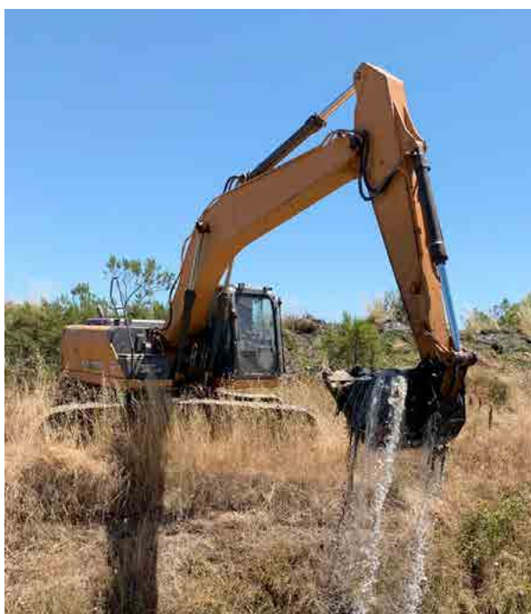
De foto superior a inferior Foto 1 y 2: Automatización Compuerta desarenador Foto 3: Limpieza de canales
