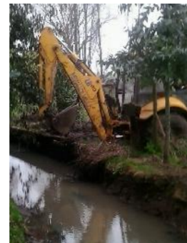
Limpieza Canal Cinco Sur con máquina retroexcavadora.
