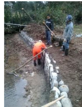
Construcción de muro en piedra en Canal Los Buitres (1° Sección).
