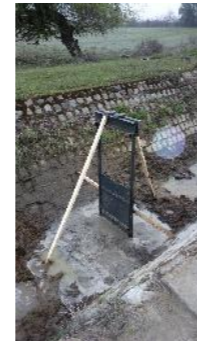
Instalación de compuerta de regulación en Canal Las Astillas.
