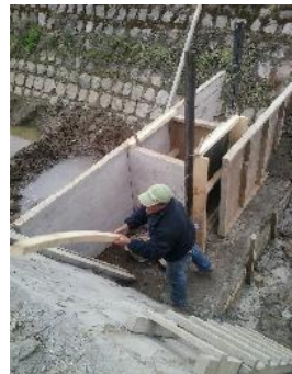
Confección de muros en Canal Las Astillas para instalación de compuerta.
