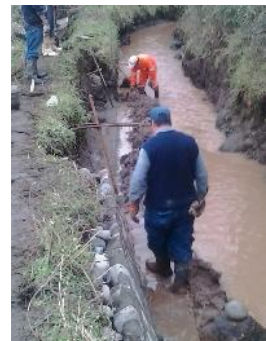
Construcción de muro en piedra en Canal Vergara Guindo.
