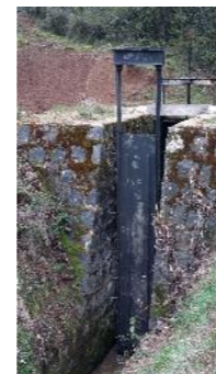
Reemplazo de compuerta en Carretones en CMNA (2° Sección).
